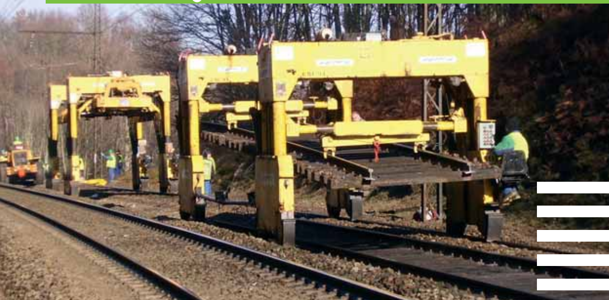
◀ Pose au portique.
